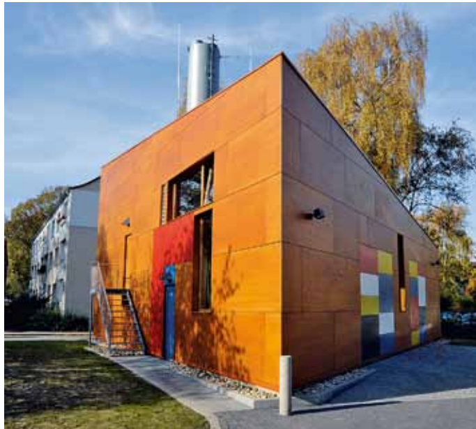
Ein modernes Heizwerk verfeuert Holzpellets und hält so 158 Wohnungen in Dortmund-Wambel warm
