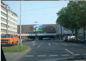
Bestand Unterführung Worringer Platz
