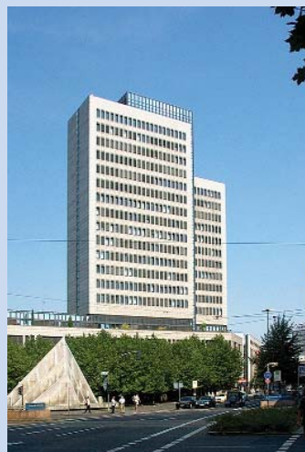
Landeszentralbank, 73,8 m Baujahr: 1987 Architekten: Philipp Holzmann AG, LZB
