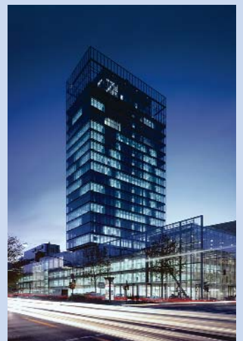
Stadtparkasse, 72,0 m Baujahr: 1964/2000 Architekten: Kraemer - Pfennig - Sieverts, Renovierung: Ingenhoven Overdiek und Partner, Düsseldorf
