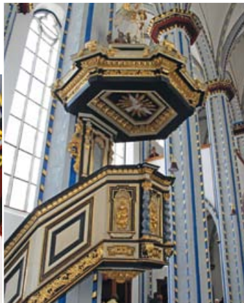
Auch das Kircheninnere erhielt im Rahmen der Sanierung einen neuen Anstrich. Fotos: P. Kilian
