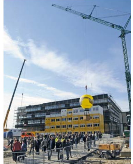
Groß war der Besucherandrang vor dem fertiggestellten Rohbau. Fotos: S. Freitag
