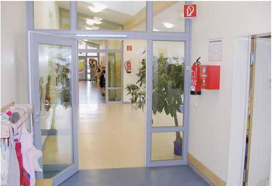
**Abb. 8 Rauchmeldergesteuerte Rauchschutztür**
