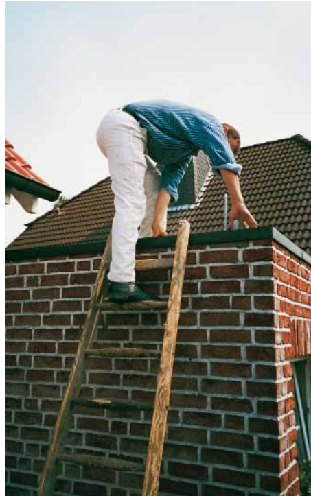
So haben die Hände keinen Halt und keinen Kontakt mit der Leiter. Mit den Beinen kann die Leiter weggestoßen werden und von der glatten Metallkante des Flachdachs leicht abrutschen.
