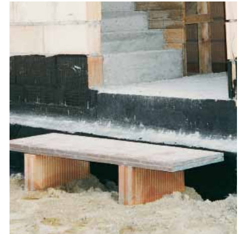
Schon besser, aber auch diese Steine können kippen die lose aufgelegten Tafeln können hochschlagen.
