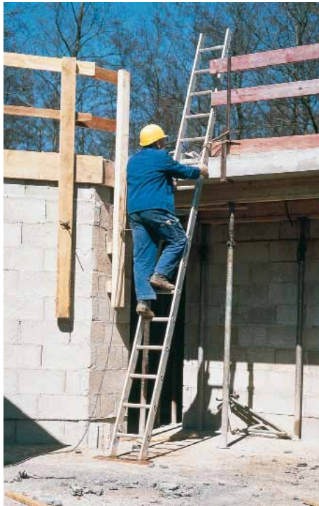
Die Leiter muss mindestens 1,0 m über die Austrittsstelle hinausragen.
