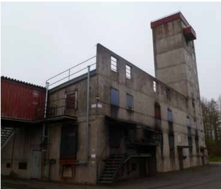
Bild unten: Treppenraum/Garage/Wohnung
