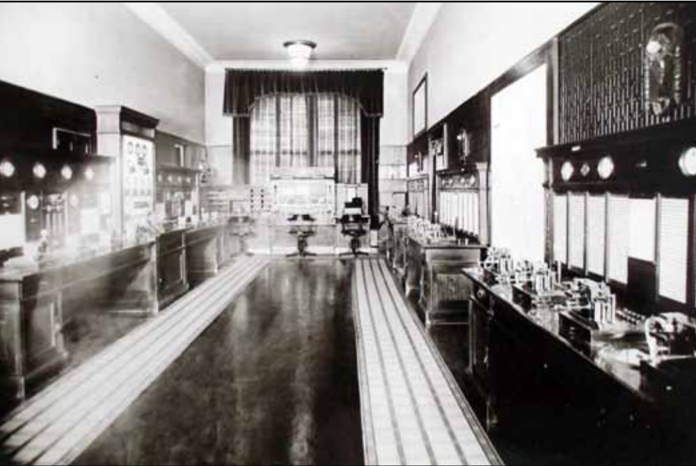
Die Telegrafenzentrale ist mit modernster Technik ausgerüstet. Hier laufen über Morseapparate alle Feuermeldungen ein, die über die Feuermelderschleifen des Stadtgebietes gemeldet werden. So ist die Branddirektion ständig über Vorkommnisse im Stadtgebiet auf dem Laufenden. Außerdem wird automatisch und ohne Zeitverlust von der Zentrale an der Münsterstraße bei einem Brand ein anderer Löschzug alarmiert, sollte die eigentlich zuständige Wache im Einsatz sein.
