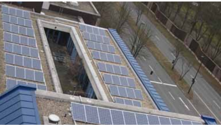
Photovoltaikanlage auf der Feuer- und Rettungswache Garath
