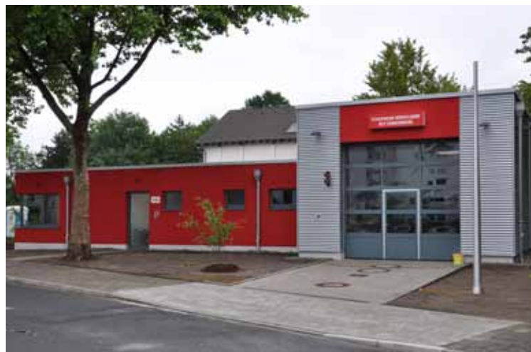
Die neue Rettungswache in Hassels. Dort ist ein Rettungswagen stationiert.
