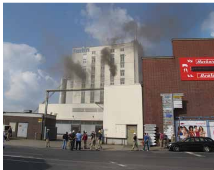
Brand im Hafen: Schwarzer Rauch dringt aus dem Gebäude – Durchzündungsgefahr
