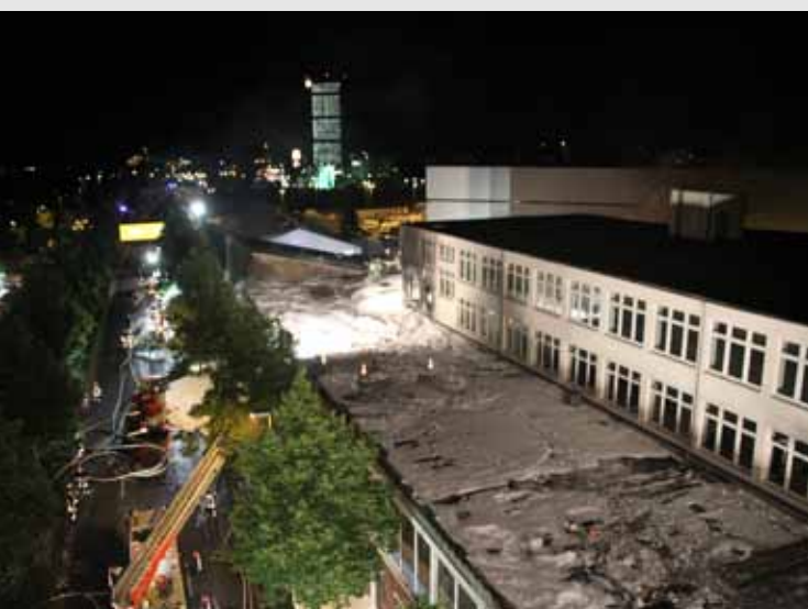
Löschschaumeinsatz: Die Feuerwehr sägte Löcher in die Holzbalkendecke, darüber wurde Schaum in die Brandräume eingeleitet. Die Öffnungen wurden zur Sicherheit mit Verkehrsleitkegeln gekennzeichnet.
