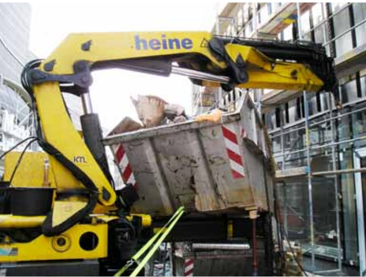
Bergung des betroffenen Baucontainers
