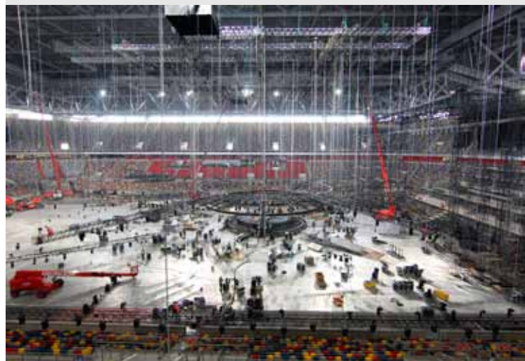
Die Umbauarbeiten zum ESC waren sehr aufwendig.
