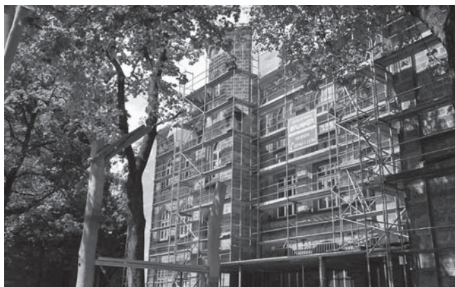
Die Stadt Krefeld investiert in diesem Jahr rund elf Millionen Euro in die Sanierung von 30 Schulen unter anderem in die Josefsschule für eine Dachsanierung.
