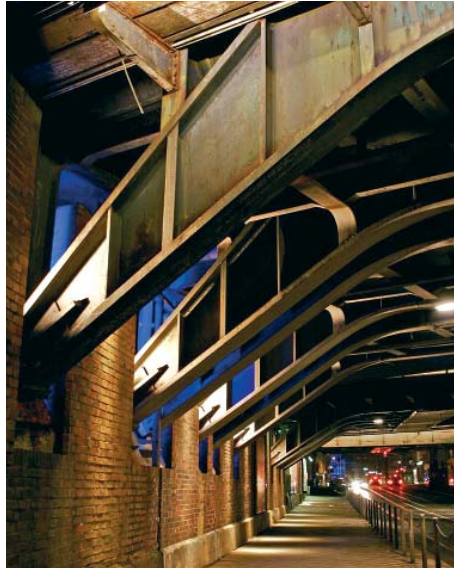
Unterführung Erkrather Straße
