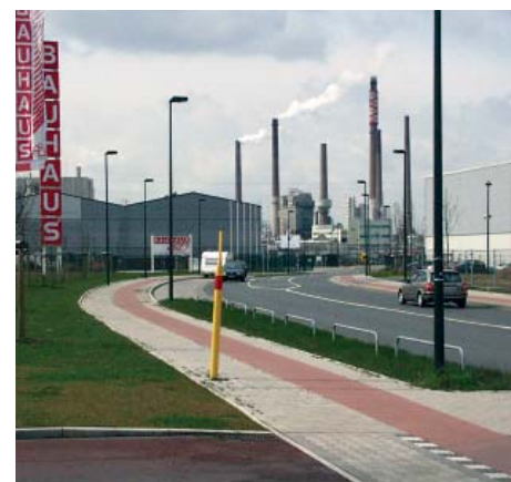
Neue Ortsumgehung / Blick nach Westen
