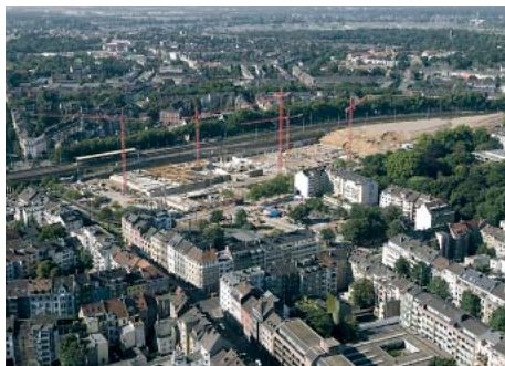
Bau der Bilk Arcaden
