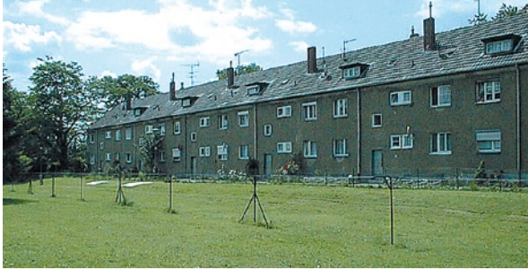
Aufstockung einer 50er-Jahre-Siedlung (Beispiel aus Köln-Neurath)
