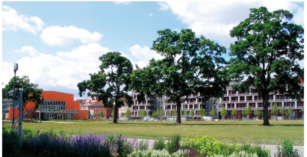
William-O.-Darby Kaserne – Gebäude 50, Fürth Architekten: Pesch und Partner, Herdecke
