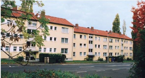
Ergänzung einer 50er-Jahre-Siedlung, Bestand und Neubau (Beispiel aus Bonn)
