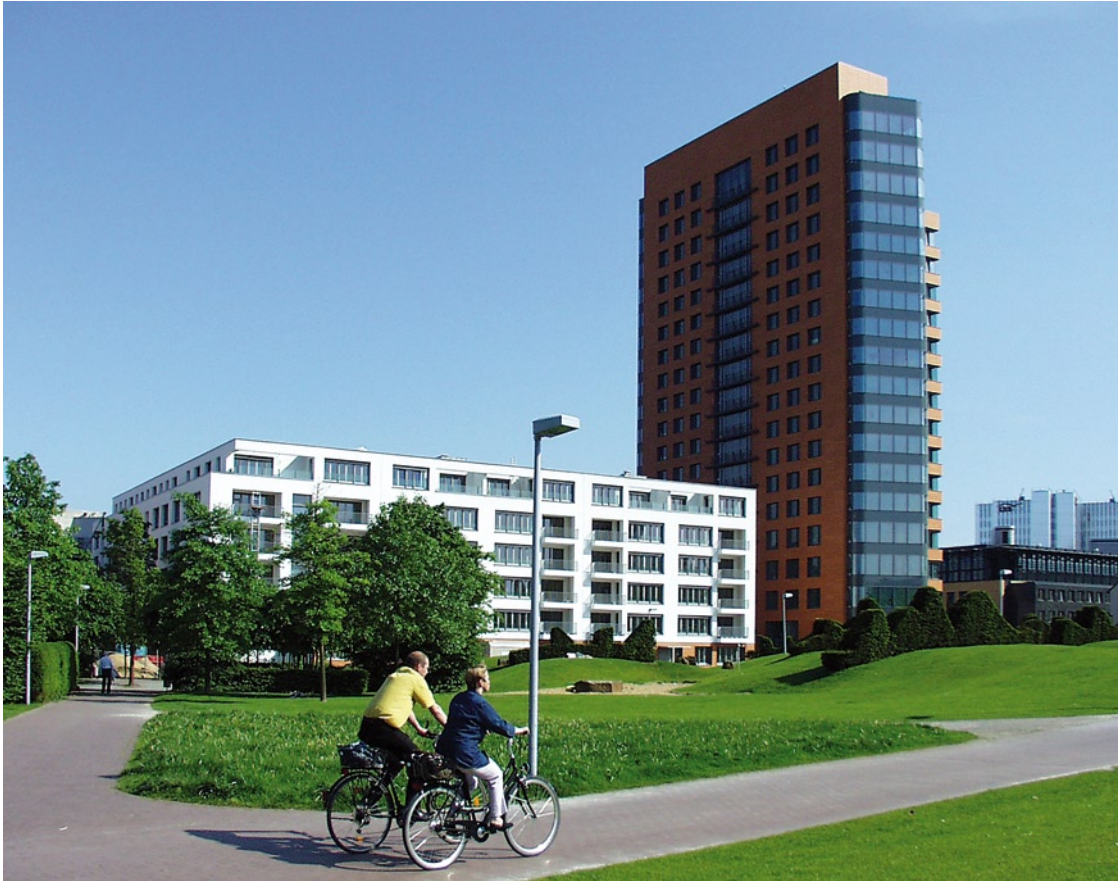
Portobello-Wohnhochhaus Architekten: Döring Dahmen Joeressen, Düsseldorf
