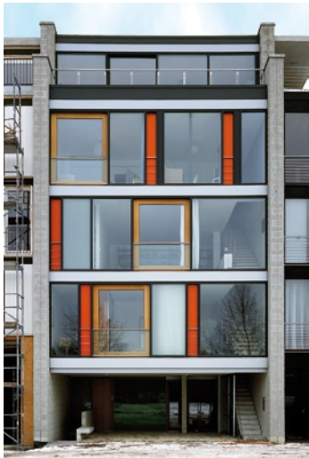
Dragoner-Kaserne, Karlsruhe Architekten: B44, Karlsruhe
