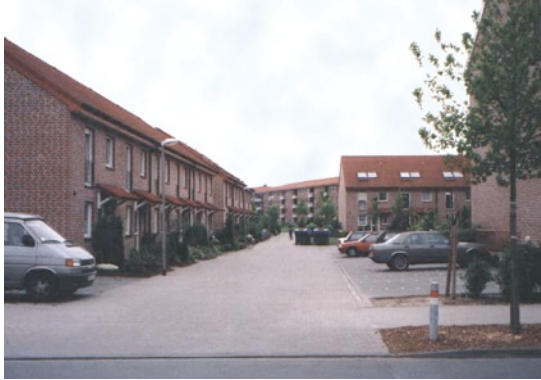
Das Produkt von gestern: Monotonie und Betonwüste, Münster
