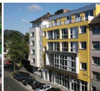
Erhaltung und Sicherung ... Fassadenprogramm
