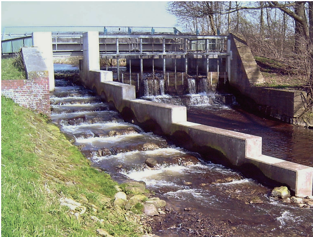
Abb. 3.1.6-1: Fischaufstieg Baumeister an der Bocholter Aa in Borken
