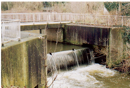
Abb. 3.1.5-3 Nicht passierbares Querbauwerk an der Ibbenbürener Aa (Dreierwalder Aa)
