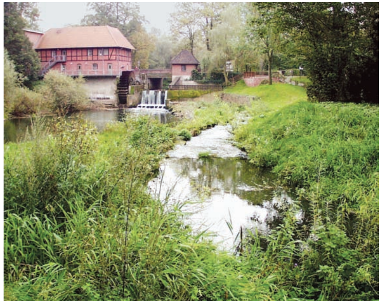
Abb. 3.1.6-1 Umgehungsgerinne am Kleinen Wehr in Telgte
