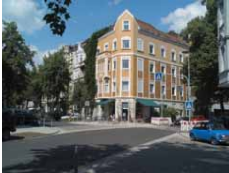
Einengung und Aufpflasterung der Straßeneinmündungen
