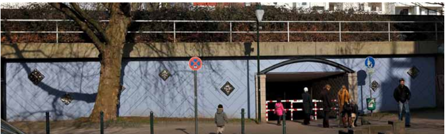
Neue Gestaltung der Unterführung Wetterstraße
