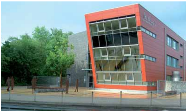
Neubau an der Lore-Lorentz-Schule, eigene Aufnahme
