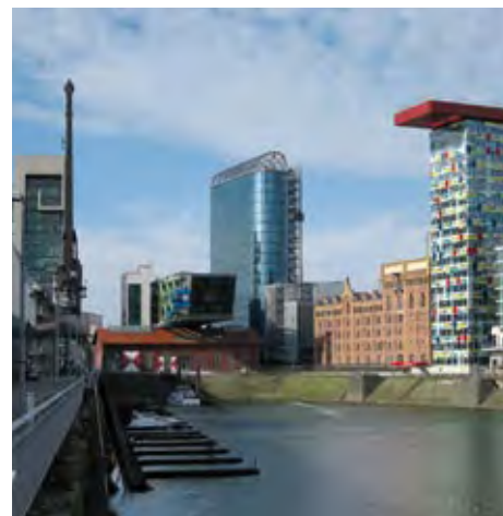
Bauvorhaben SIGN, kurz vor Fertigstellung
