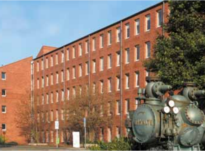
Hier brüten viele Mauersegler in Spalten unter den Fensterbänken – das Technische Rathaus in Bilk.
