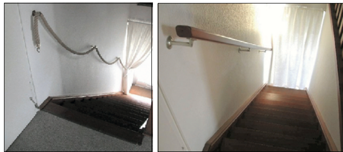
Abbildung 9 Geländer (vorher) Handlauf (nachher)
