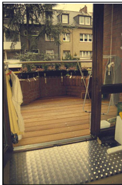
Abbildung 8 Balkonaufständerung und Rampe zum Balkon
