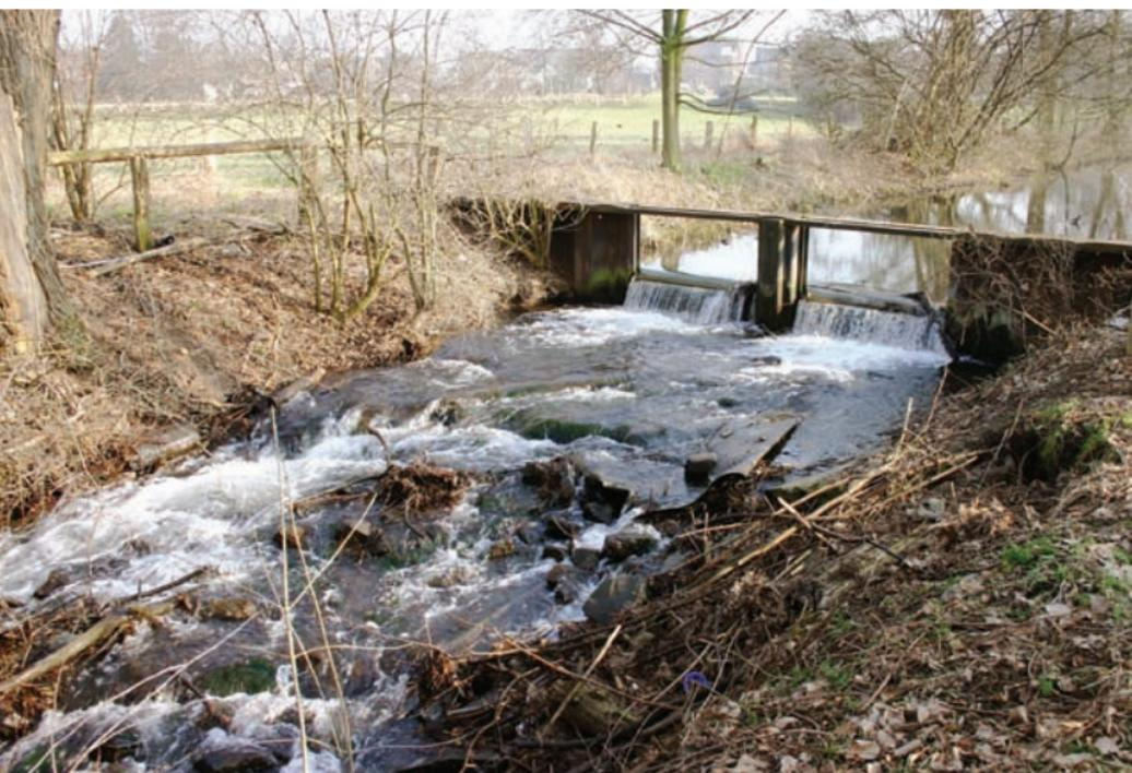
Eine besondere ökologische Aufwertung bewirkte der Umbau der Spundwände in naturnah gestaltete Sohlgleiten. Die Spundwände wurden komplett entfernt und das Sohlenniveau ungefähr um 20 cm herabgesetzt. Durch den Umbau der Abstürze wird eine Verbesserung der Durchgängigkeit und eine Wiederherstellung naturähnlicher Gefälleverhältnisse erzielt.
