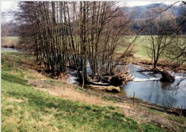
Abb. 65: Verfallende, umläufige Wehranlage an der Wenne
