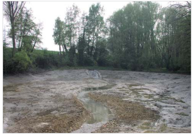
Abb. 67: Rückbau eines Teiches im Hauptschluss/Umwandlung in ein HRB mit naturnaher Gewässerentwicklung im potentiellen Staubereich
