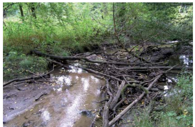
Abb. 28: Gefälleabbau flach überströmte Sandschwelle und Totholzschwelle
