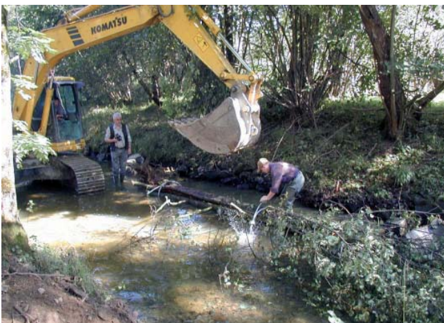
Abb. 56: Totholzeinbau mit Sicherung durch Blöcke in naturfernem Laufabschnitt der Bröl
