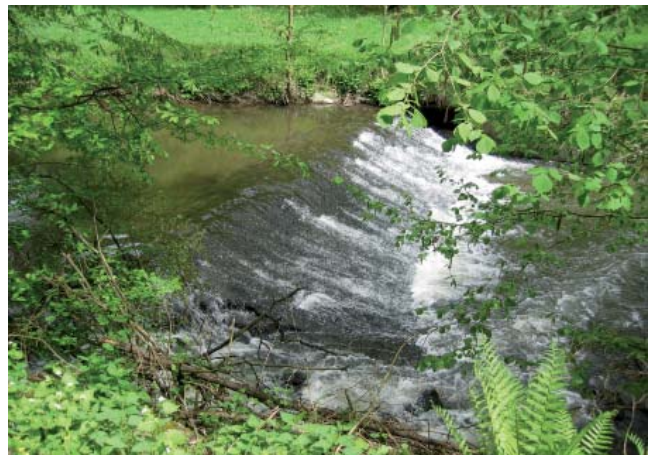
Abb. 66: Umbau eines Absturzes in eine Sohlgleite am Saynbach
