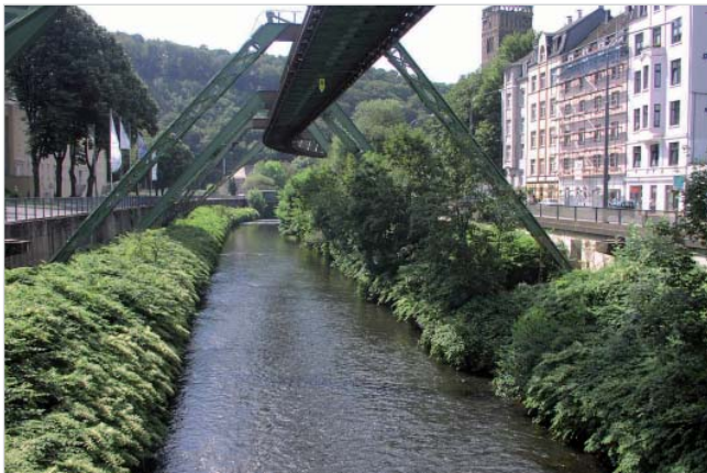
Abb. 37: Regelprofilierter Bach in freier Landschaft – Massiv ausgebauter Fluss in Stadtlage
