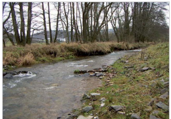
Abb. 64: Rückbau des Wehres Blankwiese an der Heller in Burbach
