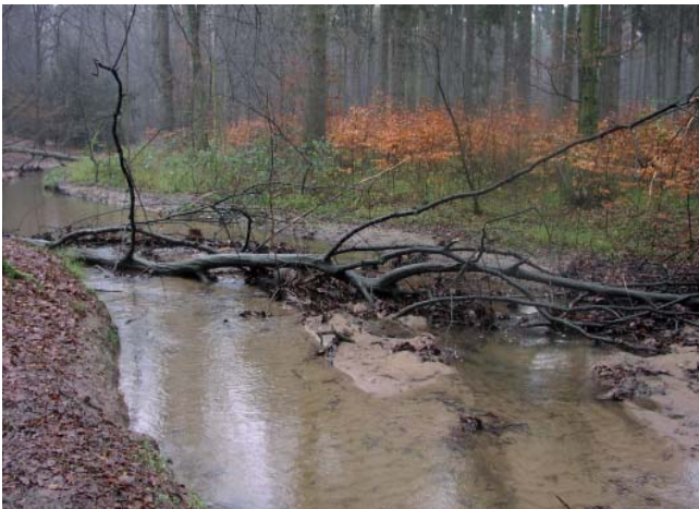
Abb. 55: Totholzeinbringung ohne Sicherung in naturnahem Laufabschnitt des Flehbaches
