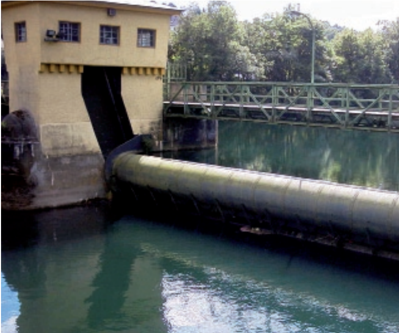
Abbildung 4: Beispiel für ein bewegliches Wehr (Quelle: MUNLV 2005)
