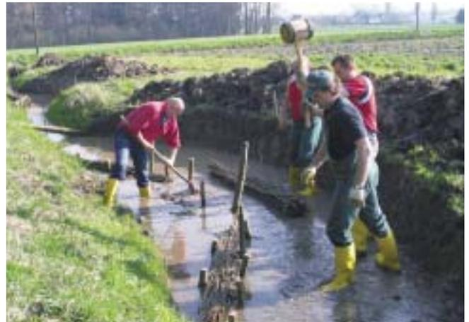
Einbau eines Strömunglenkers – Unterstützung für eine natürliche Bachentwicklung.
