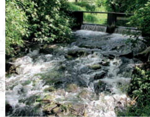
Wehr mit Sohlgleite oberhalb des Repelener Meeres
