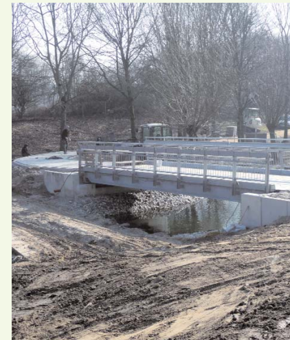
Ersatzbrücke im Jungbornpark
