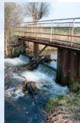
Absturz und alte Querung
