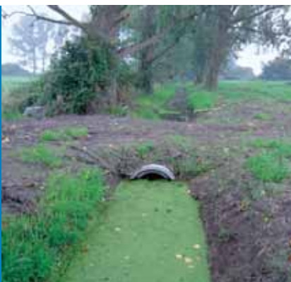
Nach der Entschlammung
