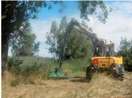
Vorarbeiten: Krautung der Uferbereiche
