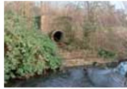
Altes Auslaufbauwerk „Utforter Tiefgebiet“
