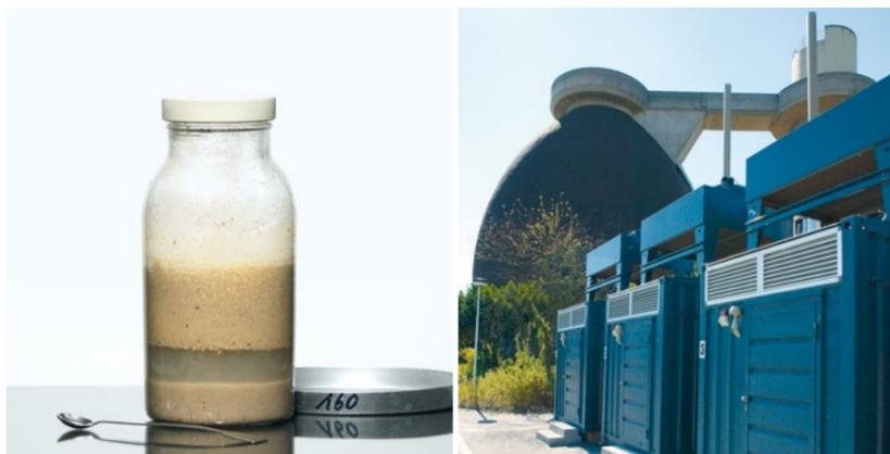
Substrate zur Co-Vergärung (links) müssen im Labor analysiert werden, um sie in den Faulbehältern (rechts) ausgewählter Kläranlagen auszufaulen und in den Blockheizkraftwerken (rechts vorn) energetisch zu verwerten.
