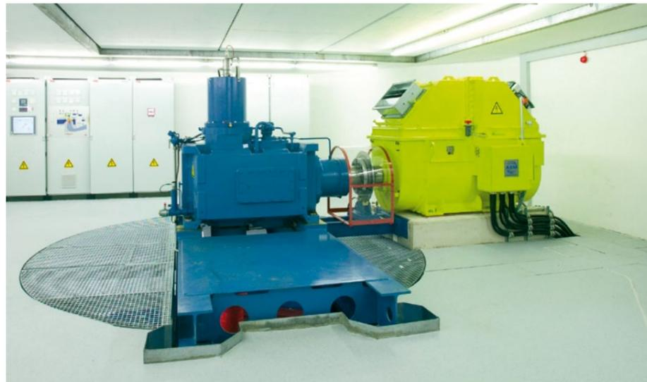
Das neue Wasserkraftwerk am Kemnader Wehr (links: Getriebe, rechts: Generator) erzeugt für durchschnittlich 1.200 Haushalte umweltfreundlichen Strom.
