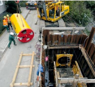
Vortriebsmaschine und Anfahr-schacht zum Bau des Stauraumkanals Deilbachufer in Essen-Kupferdreh.
