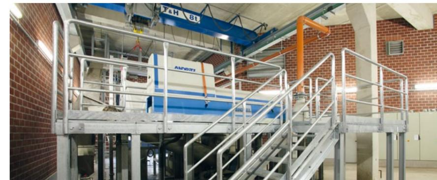
Neue Zentrifuge zur Entwässerung des Klärschlammes der Kläranlage Bochum-Ölbachtal.
