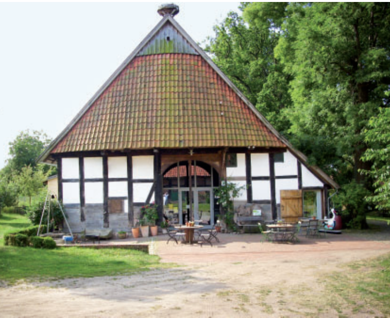
Abbildung 36: Eingangsbereich eines umgenutzten Denkmals zu einem Café in Petershagen-Windheim
