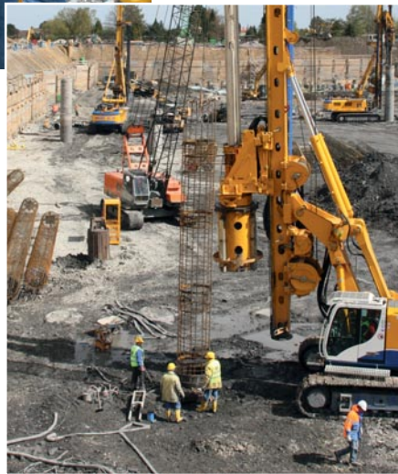
Auf dem Baugrundstück für die Fachhochschule wurden gut 400 Energiepfähle im Erdreich versenkt. Fotos: PHT Air-picture, CDM Consult, M. Muchow
