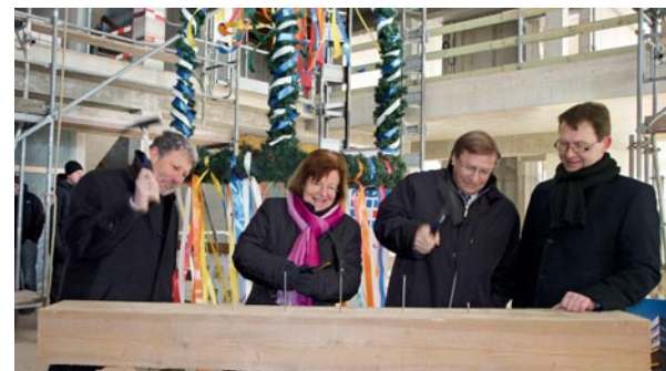
Auch NRW-Bauminister Harry K. Voigtsberger (2.v.re.) schlug beim Richtfest der Tradition folgend einige symbolische Nägel in einen Dachbalken ein.
