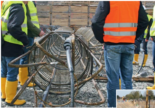
Auf dem Baugrundstück für die Fachhochschule wurden gut 400 Energiepfähle im Erdreich versenkt. Fotos: PHT Air-picture, CDM Consult, M. Muchow
