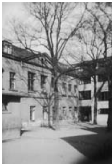
Noch in der Haderslebener Straße mit Anbau
