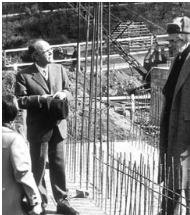
Grundsteinlegung, Herr Rauthe und Herr Böcking
