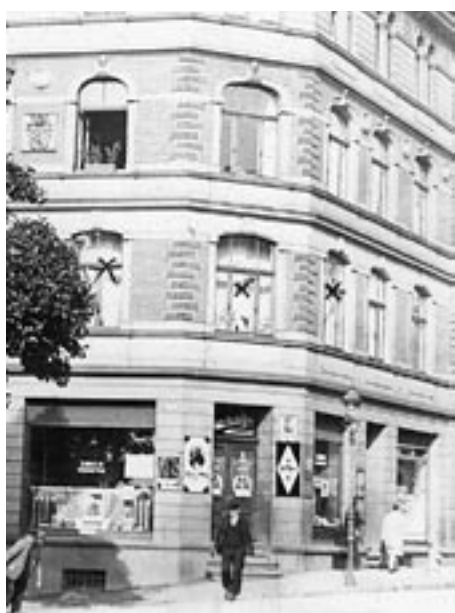
Haus der Eltern von Emmi Leyendecker: Hinter den mit einem Kreuz versehenen Fenstern tippte Luise Klesper (später Paul) illegale Zeitungen und Flugblätter der KPD.
