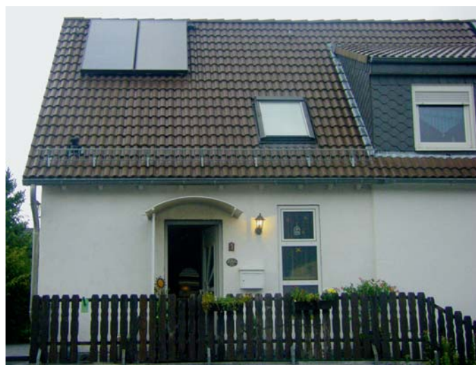
Das energetisch sanierte Gebäude der Familie Wischniewski inklusive der thermischen Solaranlage
