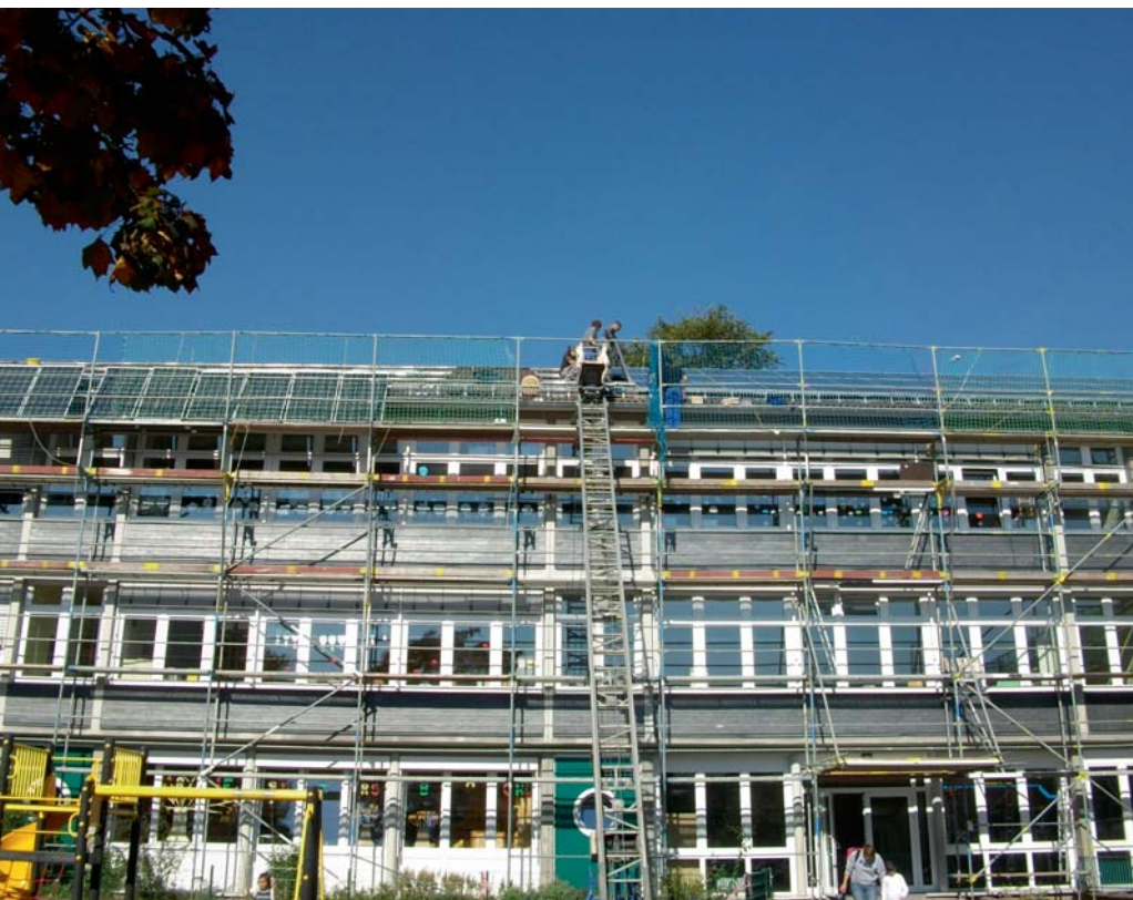
Installation der Photovoltaikanlage auf der Grundschule in der Palmstraße
