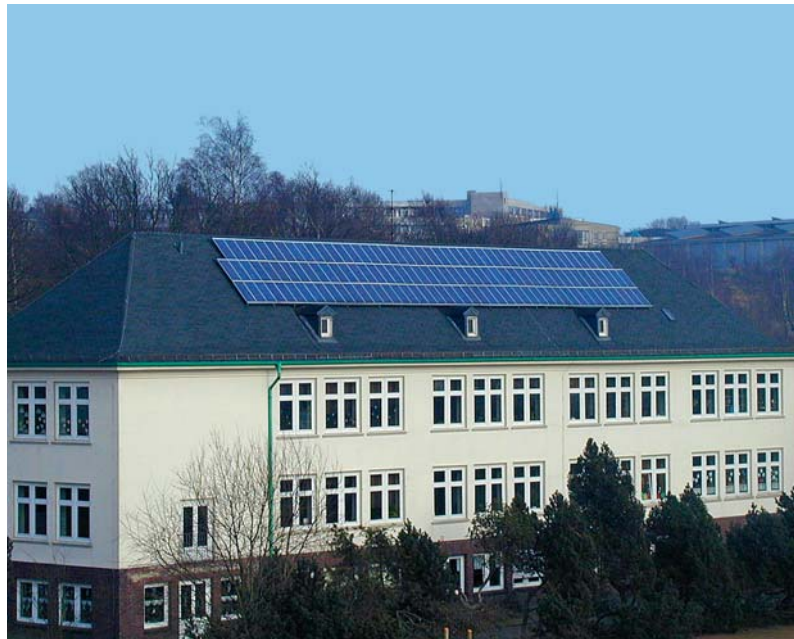
Photovoltaikanlage auf der Grundschule Walther-Hartmann
