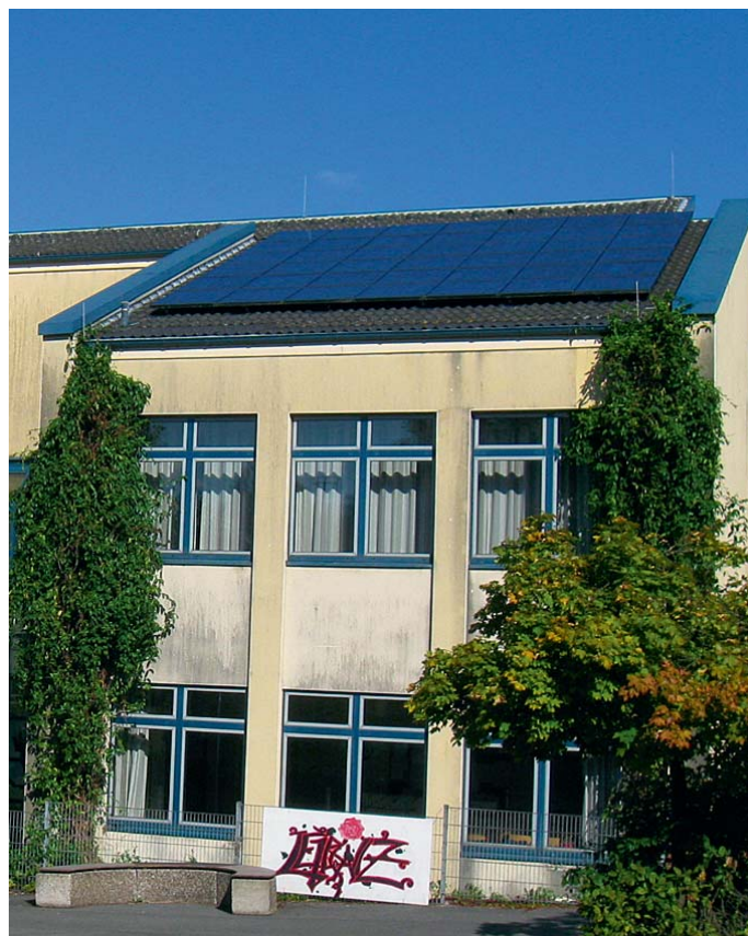
Photovoltaik-Gemeinschaftsanlage auf dem Schulzentrum Klausen
