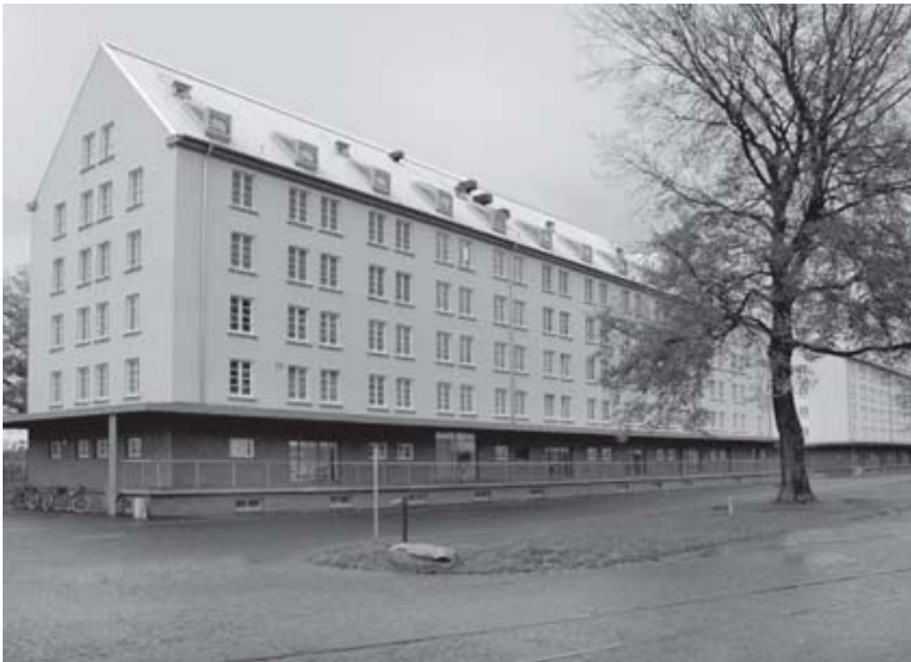
Speicher Nr. 4 und Nr. 5 nach dem Umbau 10
