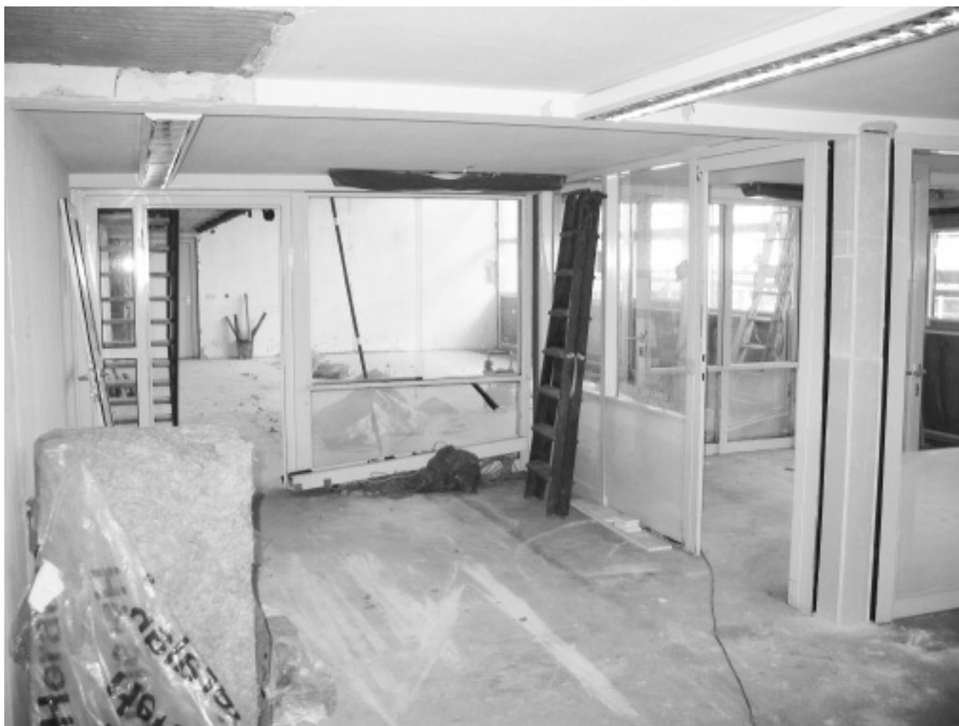
Bauarbeiten im entkernten Lesesaal (Foto: Peter Fröhlich/Landesarchiv NRW)
