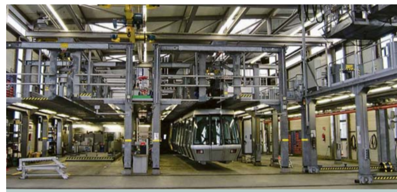
In der oberen Etage des SkyTrains Betriebshofs befindet sich die Wartungshalle für die Züge. Hier kann an zwei Zügen gleichzeitig gearbeitet werden.
