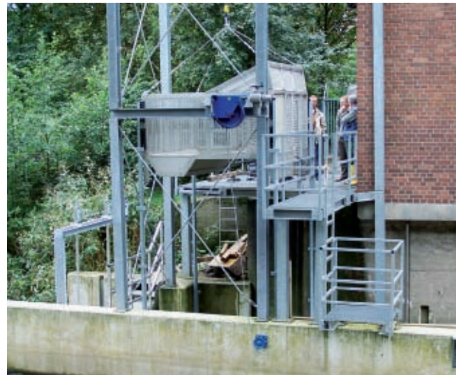
Kontrollstation Auermühle an der Dhünn
