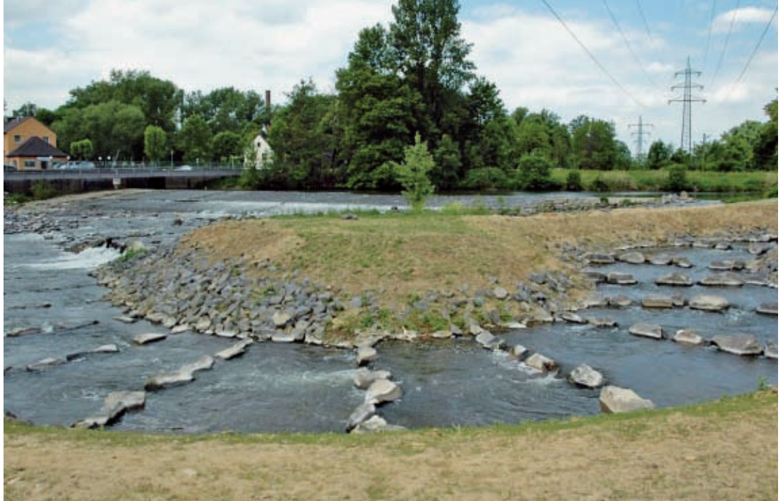
Fischpass bei Troisdorf an der Agger
