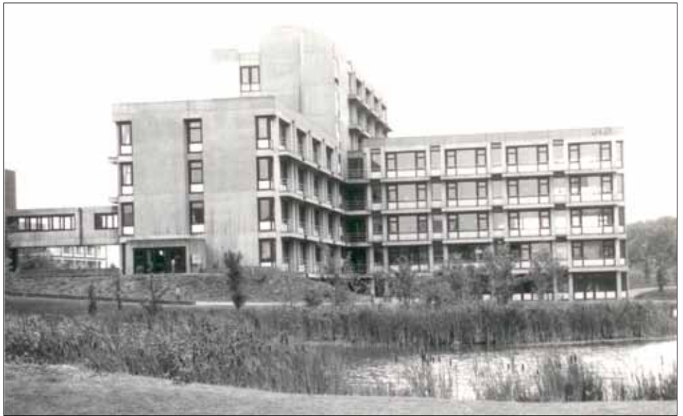
Gebäude 24.21 am Standort Süd 1977 nach Bezug durch den Fachbereich 6
