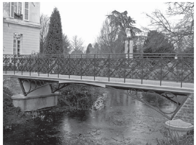
Die Restauration an der Brücke über den Graben rund um das Haus Sollbrüggen ist abgeschlossen.
