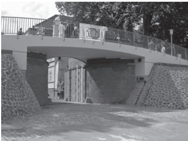
Die Geschichte des Uerdinger Rheintores reicht bis in das 19. Jahrhundert zurück. Jetzt ist das Bauwerk umfangreich saniert worden.
