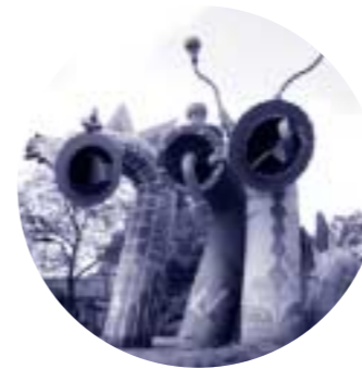
Lüftungsbauwerk des Hauptsammlers Süd (Nessy)
