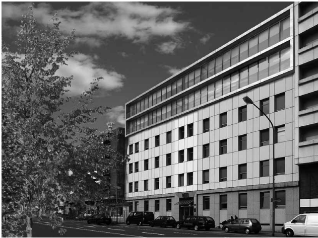
Frischer Look: Mit dem Umbau schafft das RWI mehr Raum für seine Mitarbeiter, wird barrierefrei und umweltfreundlicher
