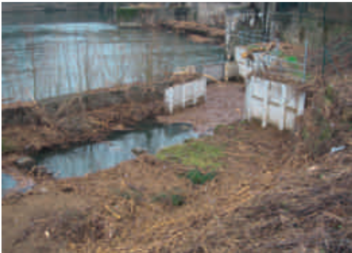
Bild 11.5: Geschwemmsel und Treibgut im Mündungsbereich der Fischaufstiegsanlage Harkortsee nach einem Hochwasser
