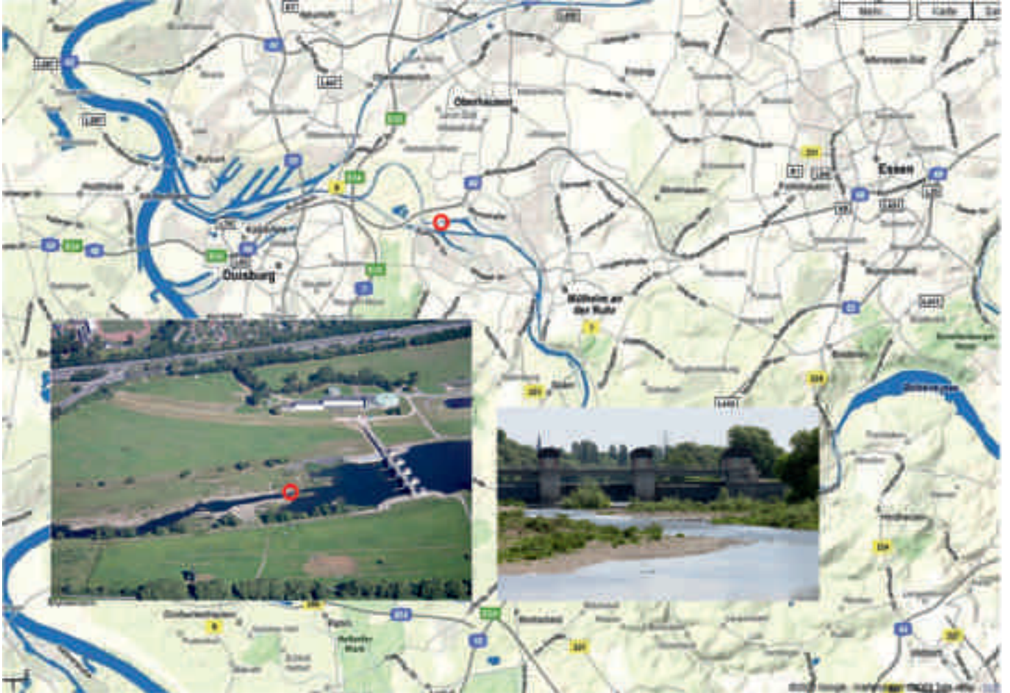
Bild 12.11: Lagekarte und Luftaufnahme des Wehres Mülheim-Raffelberg mit Fundort der Lachse Fig. 12.11: Map and aerial view of the Mülheim-Raffelberg weir and the locations where salmon were spotted
