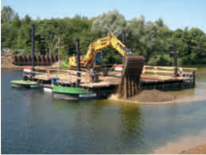
Bild 21.2: Die Baggerarbeiten im Ruhrbett fanden unter optimalen Abflussbedingungen der Ruhr statt. Fig. 21.2: Excavator work in the Ruhr bed took place under optimal runoff conditions
