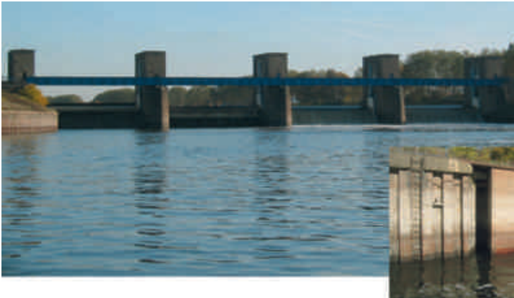
Bild 12.7: Erstes Ruhrwehr in Duisburg, Wehr und Einstieg in den Fischweg
