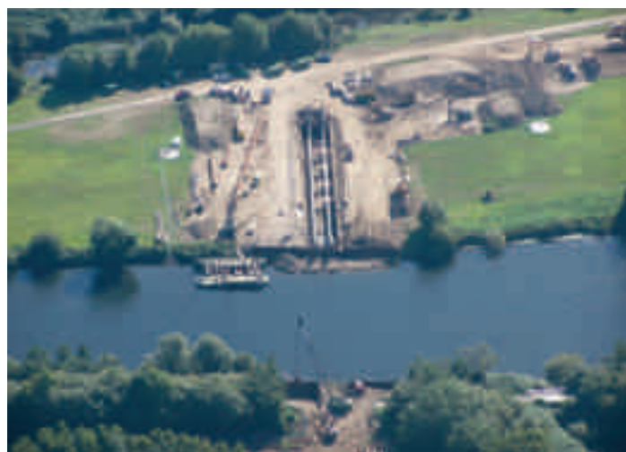
Bild 21.1: Das Trockendock mit dem in der Fertigung befindlichen Düker aus der Vogelperspektive
