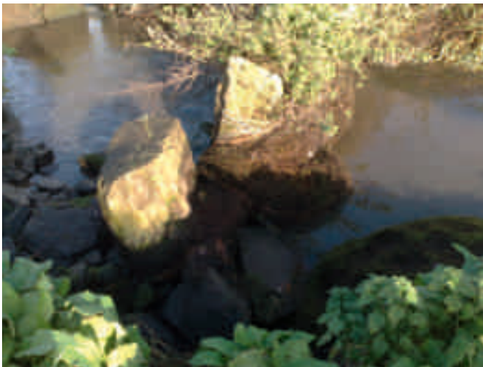
Bild 11.6: Elodea-Polster versperren die Durchlässe zwischen den Steinquerriegeln des Raugerinnes im Fischaufstieg Harkortsee und verhindern damit die Durchgängigkeit für Fische.
