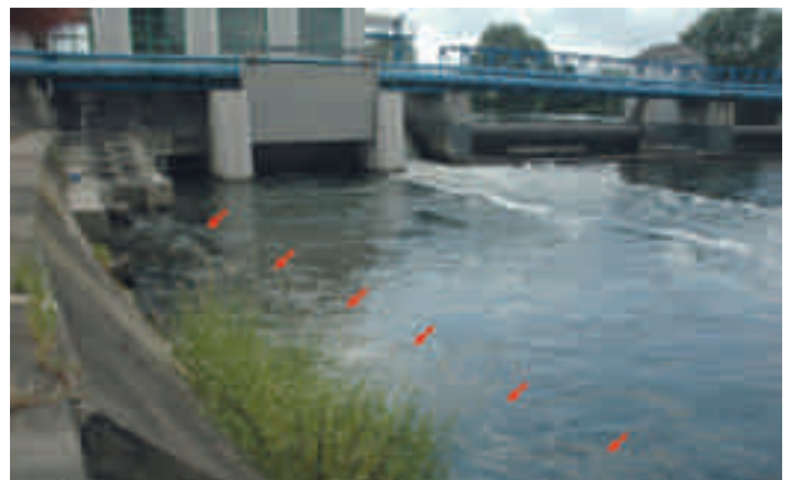
Bild 23.2: Verbesserung der Lockströmung nach Reaktivierung der Wasserkraftanlage im Jahr 2007/2008.
