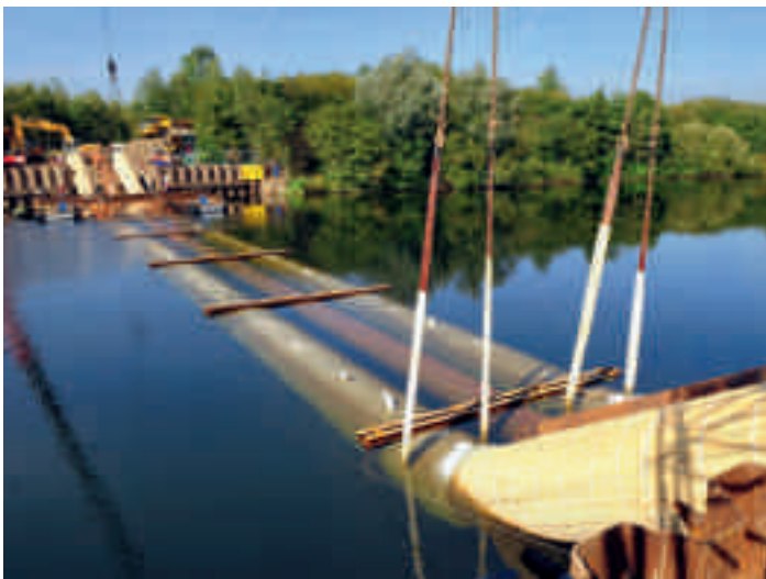
Bild 21.3: Der Düker befindet sich direkt über dem ausgehobenen Ruhrbett und wird nun abgesenkt. Die auf dem Rohrscheitel sichtbaren Tüllen stammen von der Textilschalung der Betonummantelung. Fig. 21.3: The siphon above the excavated Ruhr bed, about to be lowered. The spouts visible on the soffit originate from the textile lining of the concrete casing
