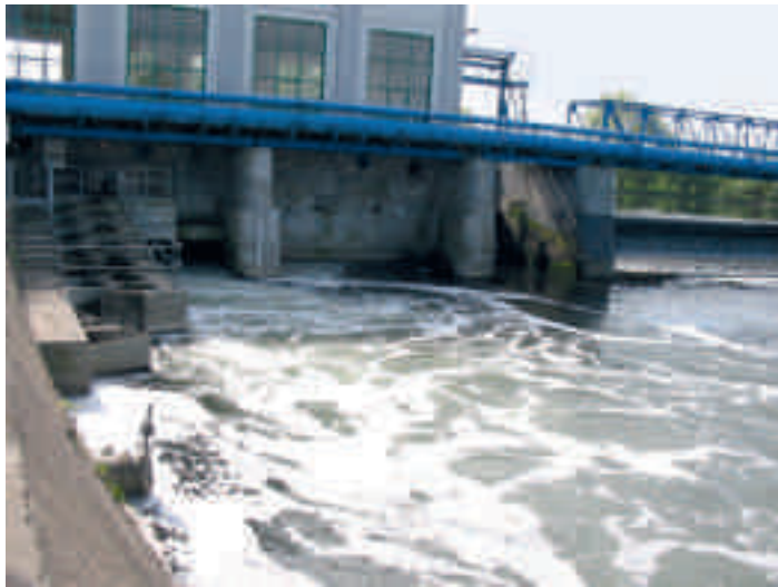
Bild 23.1: Luftblasent Teppich, hervorgerufen durch ungünstige Strömungsverhältnisse vor Einbau der Turbine. Am linken Bildrand ist der Fischpass zu erkennen.
