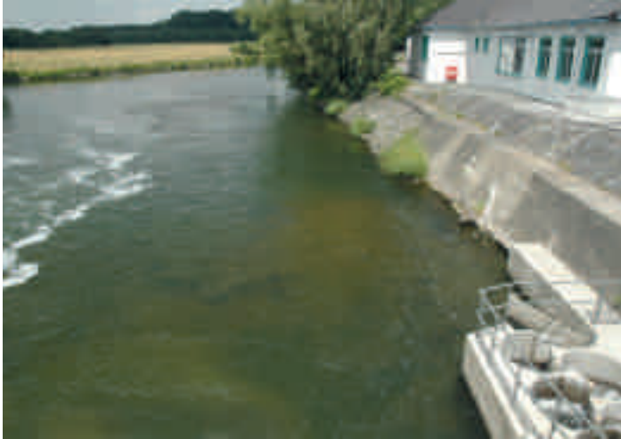
Bild 23.3: Blick nach Unterwasser. Gut zu erkennen ist die klare Strömungsführung zum Einstieg des Fischpasses hin. Fig. 23.3: Underwater view. The flow direction toward the fish bypass entrance is clearly visible.
