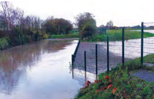
Einstau HRB Schwarzbach/Kalkum
