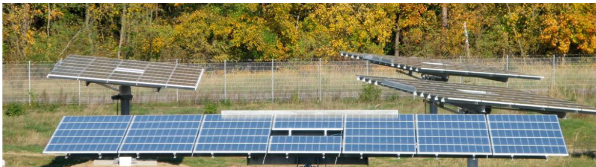
Solarpark Feldheim (Quelle: Agentur für Erneuerbare Energien)
