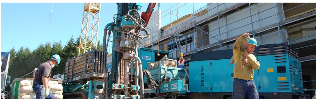
Bohrung für Wärmepumpe (Quelle: Agentur für Erneuerbare Energien)
