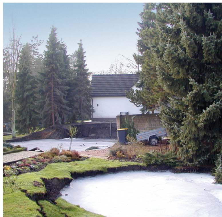
Tagesbrüche in Wattenscheid-Höntrop, verfüllt mit Beton
