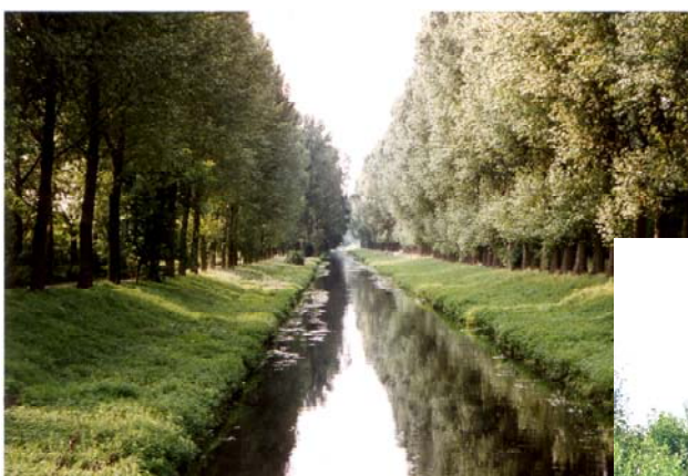
Als intensiv gepflegtes Trapezprofil führt der gerade Nierslauf das Wasser schnell ab, bietet aber trotz guter Wasserqualität wenig Lebensraum für Pflanzen und Tiere.
