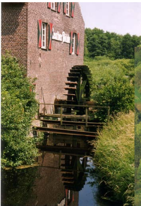
Wassermühle mit unter-schlächtigem Rad
