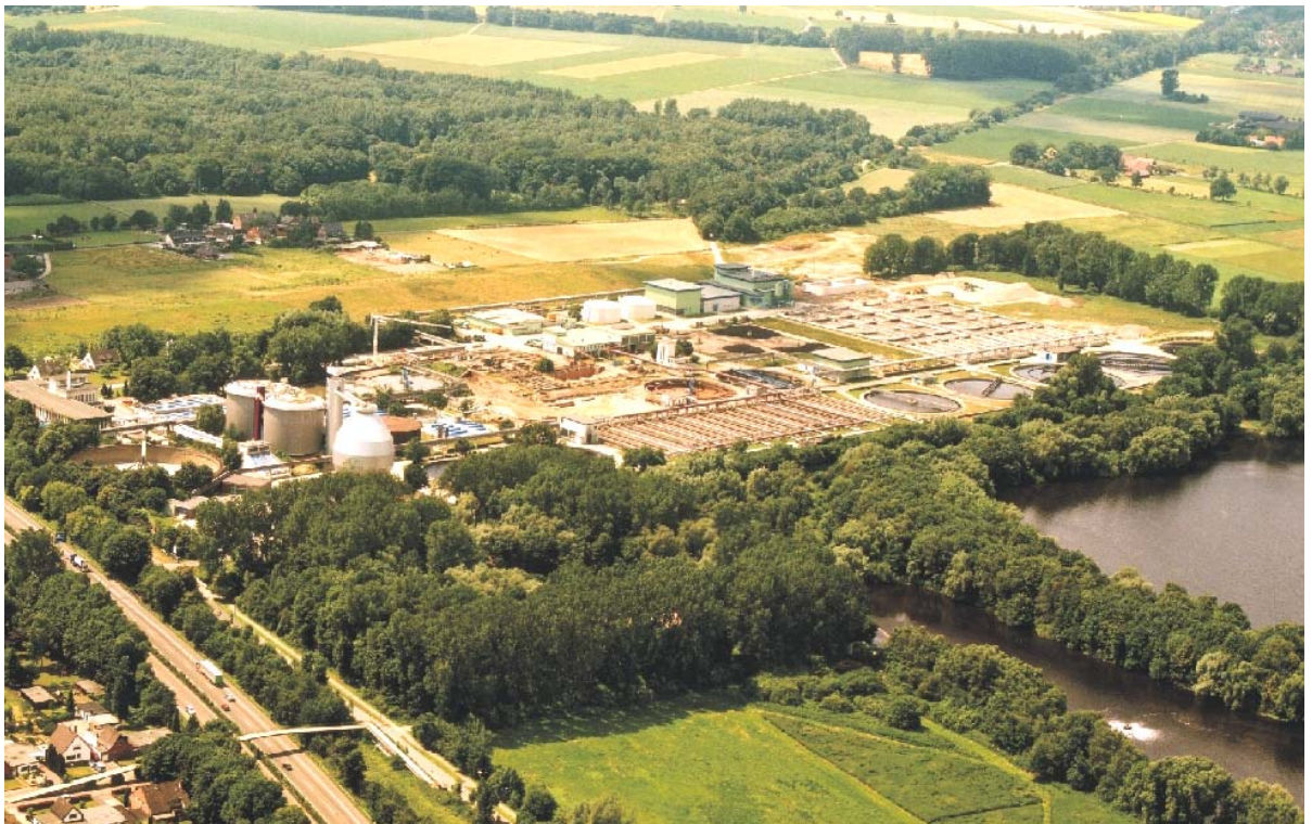
Klärwerk Mönchengladbach Neuwerk; steigende Anforderungen an die Klärleistung machen ständige Erweiterungen und Umbauten notwendig.
