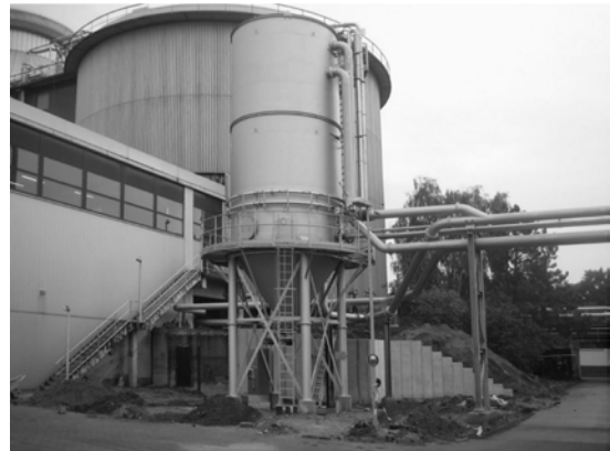
Reaktor I der MAP-Fällungsanlage (im Hintergrund die Faulbehälter)
