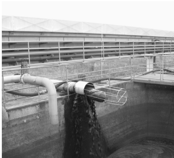
Molch beim Austreten aus der Leitung
