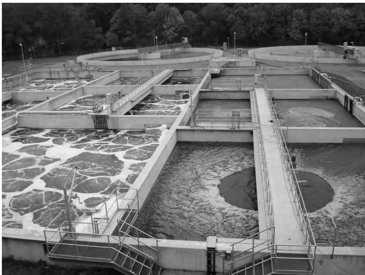
Klärwerk Geldern: Inbetriebnahme biologische Stufe
