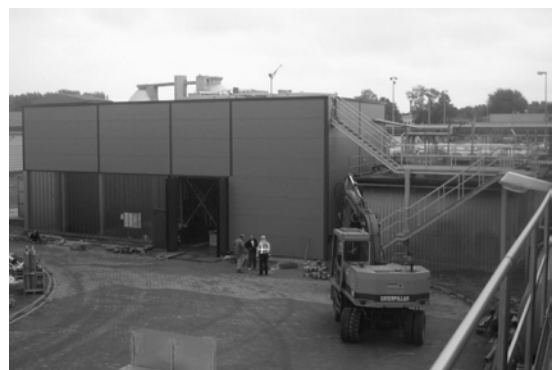
Neue Maschinenhalle für die Reaktoren II und III der MAP-Fällungsanlage
