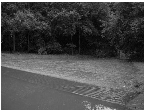
Bilder des RRB auf der BST Hessenbende beim gleichen Regenereignis vom 03.07.2009: Das vollgefüllte RRB (links) entlastet über die Dammkrone (rechts)
