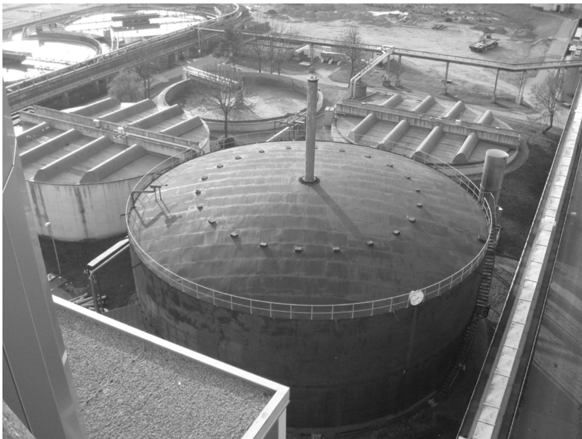
Klärwerk MG-Neuwerk – Blick auf den Gasbehälter
