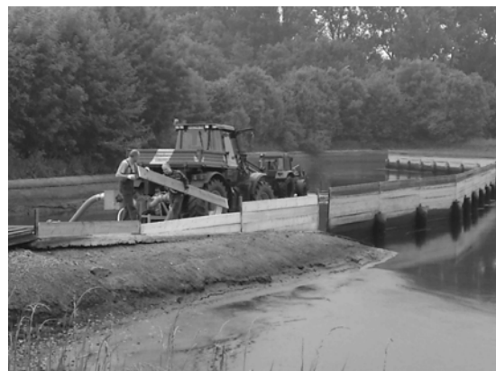
Karl Elsemann und Thomas Beiten bei der Erneuerung der Trennwand am Teich 2
