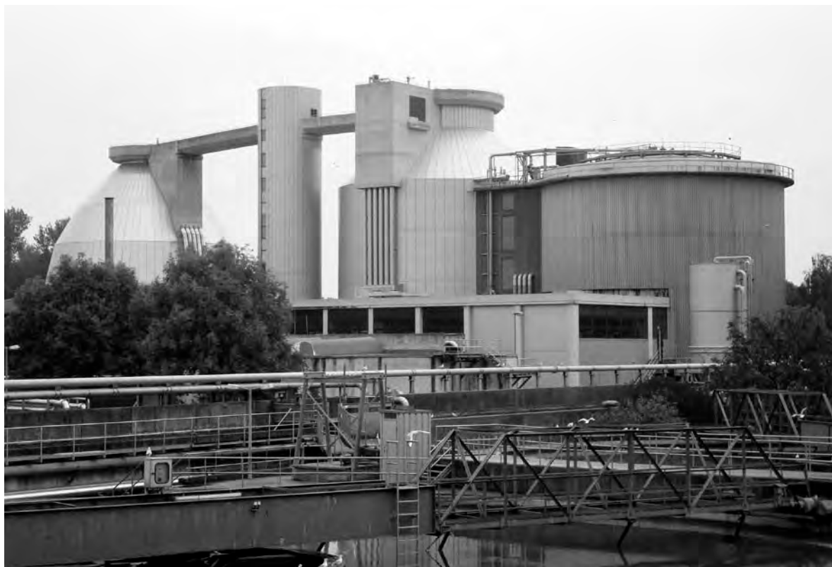
KW Mönchengladbach-Neuwerk: Faulbehälter 2 – Abschluss der Sanierung
