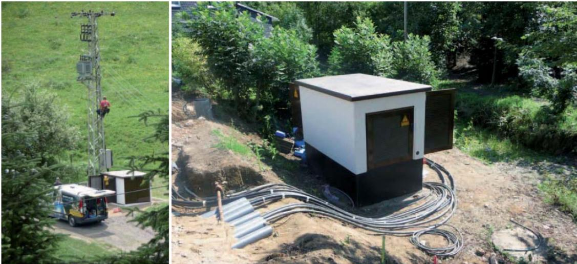
Links: Austausch einer 10-Kilovolt-Maststation gegen eine Kompaktstation. Rechts: Neue 10-Kilovolt-Ortsnetzstation in Niederhelden.
