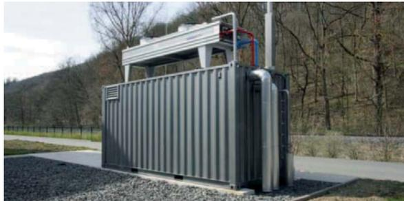
Mit Blockheizkraftwerken (hier: Kläranlage Sundern) erzeugt der Ruhrverband Energie und senkt so den externen Strombezug.
