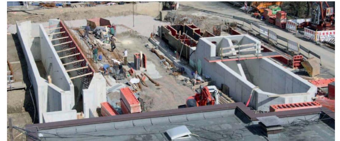
Zulaufpumpwerk und Sandfang der Kläranlage Wenden im Rohbau.
