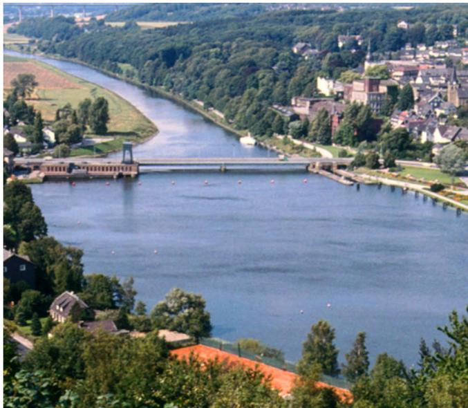
In Kettwig wurde das zweite Sektorwehr in Deutschland errichtet, dessen hydraulischer Antrieb Windwerke überflüssig machte. Daher konnte eine neue Straßenbrücke unmittelbar über den Wehrpfeilern errichtet werden. Konstruktionsbedingt ist die Übertragung des Wasserdrucks direkt auf die Wehrfundamente äußerst günstig.
